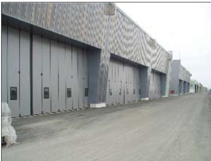
Portes accordéon roulantes motorisées de 18 mètres de large et 6 de haut, réalisées pour le bâtiment maintenance hélicoptères du Génie de Bordeaux.
